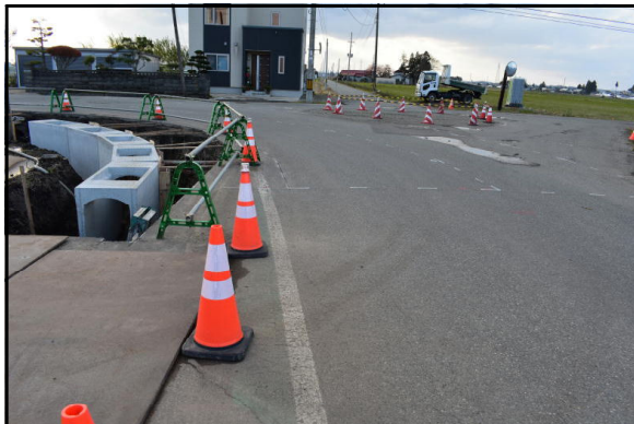
ロータリーと歩道 12月13日まで工事中です 気を付けることは…！
