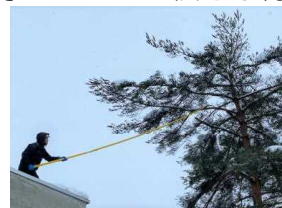
校舎の2階からの伐採作業
