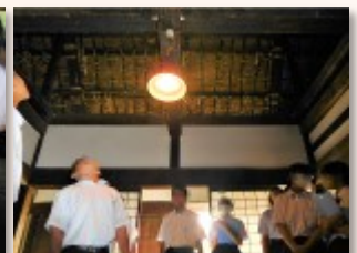
天井が吹き抜けになっている部屋も
