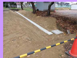
埋立工事終了しました。
