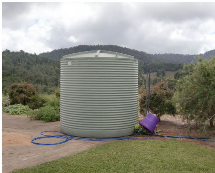
<大きな貯水タンク>
