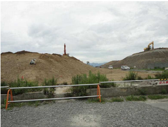
・復旧工事（盛土して造成）が進められているが まだまだ、時間がかかりそう。
