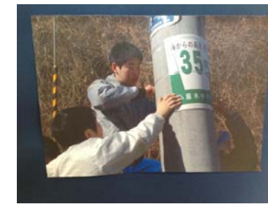
(海拔表示板の取り付けの様子)
